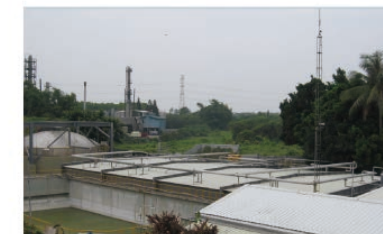
處理單元加蓋並 設置廢氣收集管線
