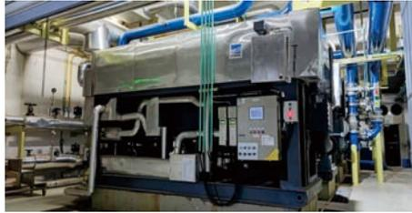
☑RTO一、二線出氣側雙碟閥處利用空壓機提供的高壓空氣密封，現已將RTO二線改為高壓風機補氣，達到每年節電72,000千瓦小時的效果。
