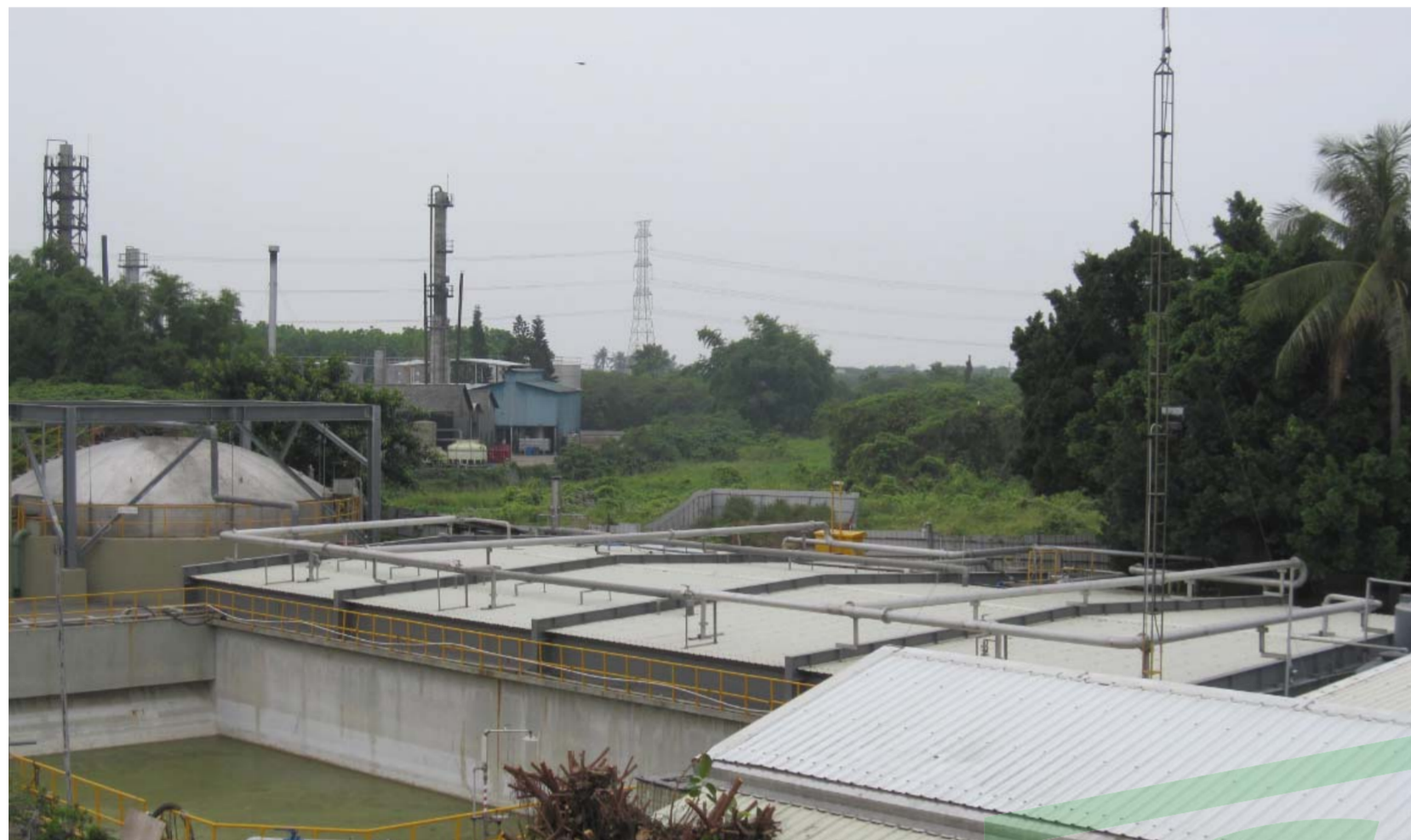
處理單元加蓋並設置廢氣收集管線
