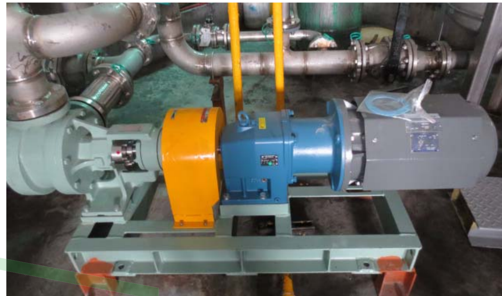
更換泵浦軸封不易洩漏型元件
