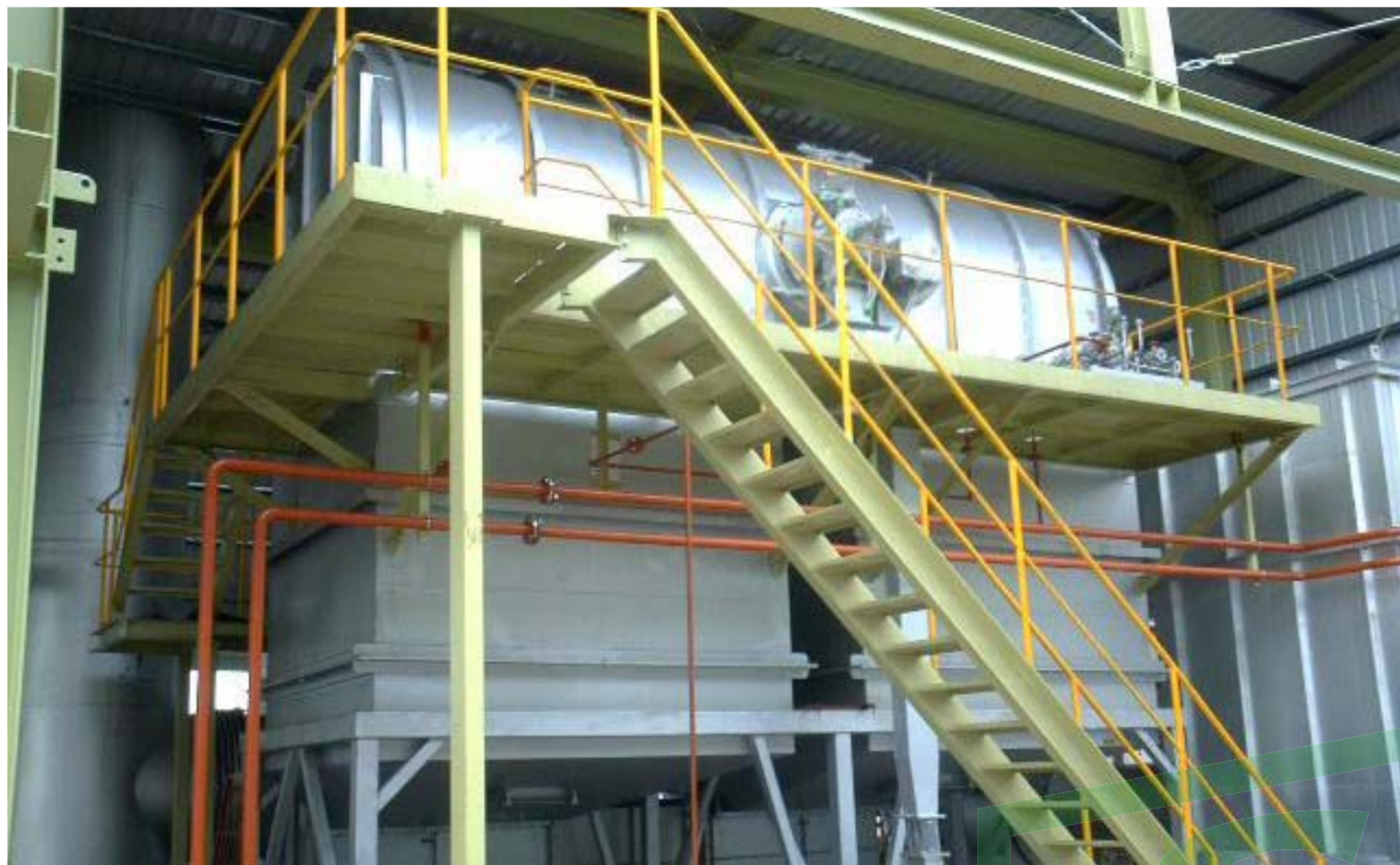
RTO 廢氣焚化爐防制設備
