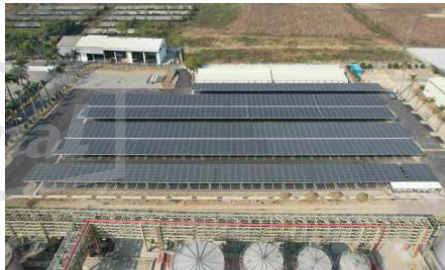
註：路竹廠太陽能發電建置工程實景圖
