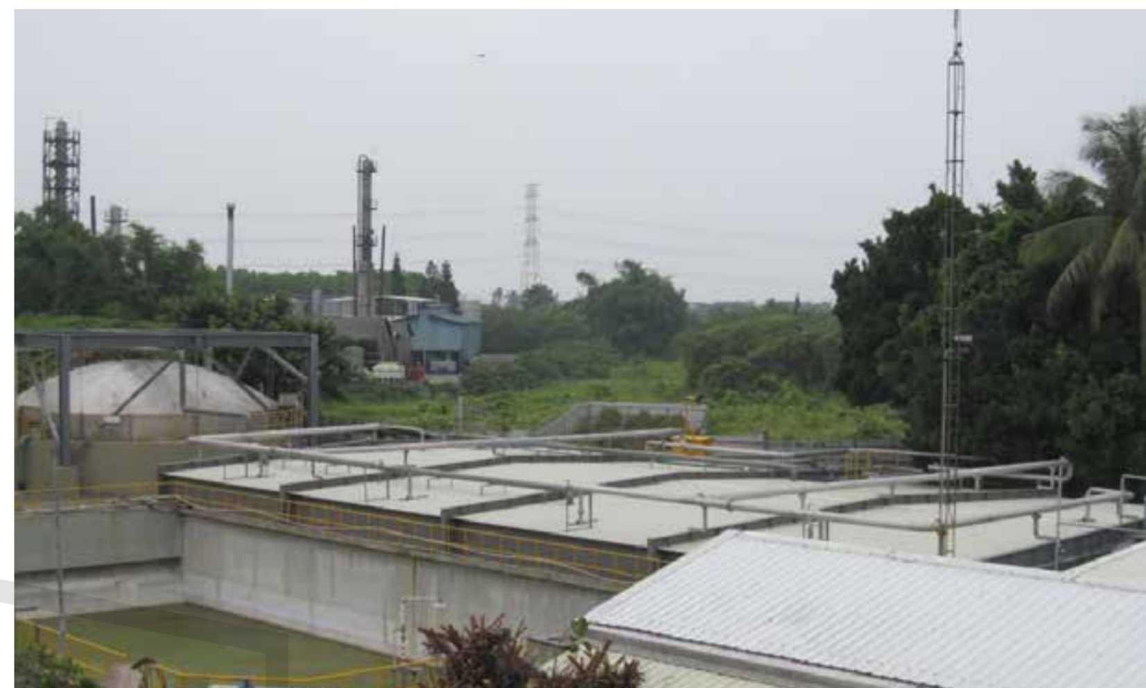
處理單元加蓋並設置廢氣收集管線
