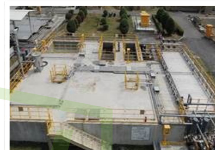
▲ 廢水處理設備 (薄膜生物反應器)
